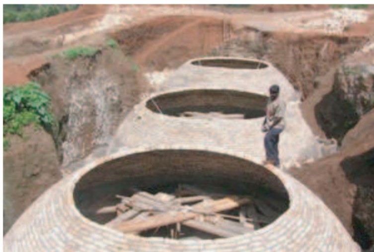
Figura 14: Planta de producción de biogás en construcción en Kigali, Ruanda información detallada en www.ashdenawards.org/winners/kist05
