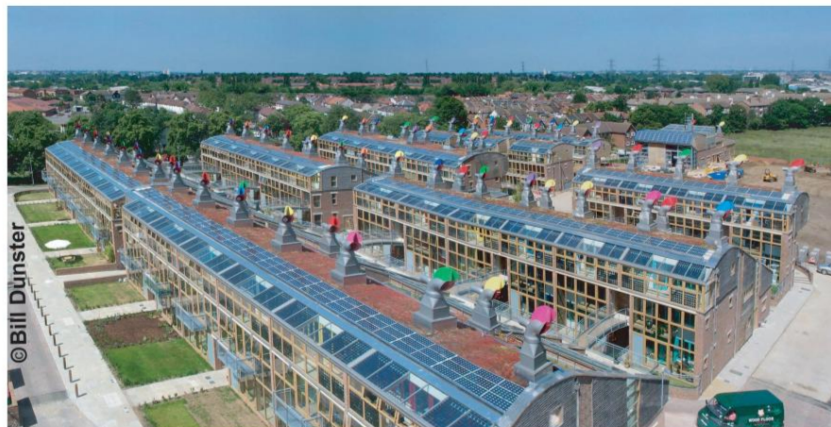
Figura 6: BedZed, con paredes orientadas al sur que absorben el sol
